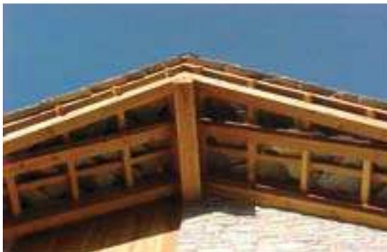
La maggior parte degli edifici antichi si presenta con pianta irregolare, imponendo alle falde di copertura geometrie particolari di non facile percezione ad un esame superficiale. Sovente, per evitare l'effetto ad "elica" delle falde, il colmo è disposto in pendenza oppure non è in asse con il fabbricato: espedienti adottati per migliorare l'estetica e la funzionalità del tetto.
