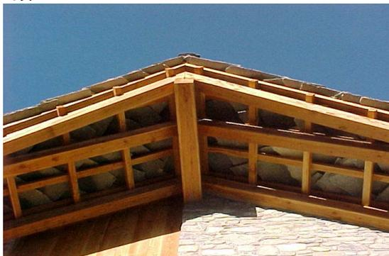
La maggior parte degli edifici antichi si presenta con pianta irregolare, imponendo alle falde di copertura geometrie particolari di non facile percezione ad un esame superficiale. Sovente, per evitare l'effetto ad "elica" delle falde, il colmo è disposto in pendenza oppure non è in asse con il fabbricato: espedienti adottati per migliorare l'estetica e la funzionalità del tetto.
