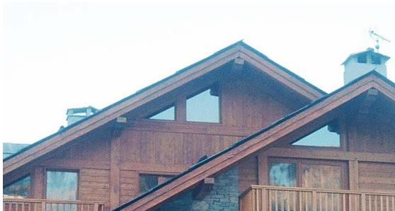
211. Aperture tradizionali a nastro poste sotto una falda del tetto
